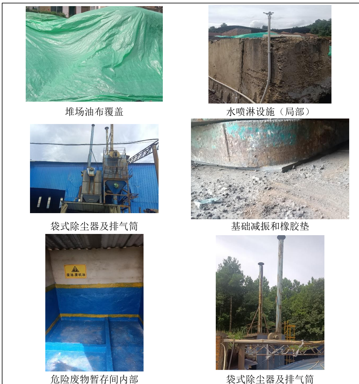
图3-3 项目部分环保设施图
